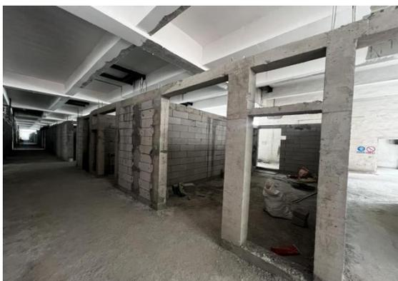
配电功能区砌墙隔断进度
